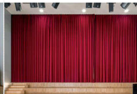
Bühnenvorhanganlage in Aula
