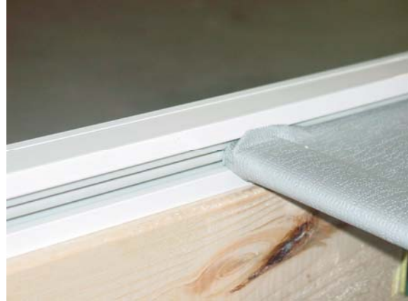
Bild 7 Führung Behang in Führungsschiene
