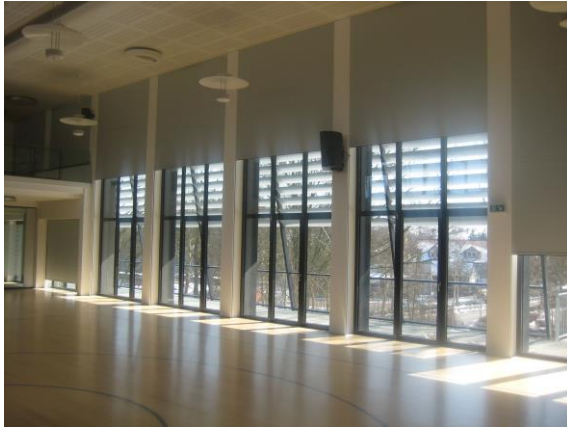
Bild 1: Einsatzbereich in einer Sporthalle
